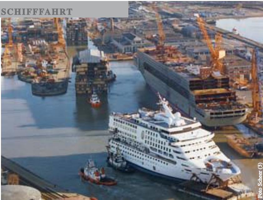
Das neue Mittelstück wird eingeschleppt.
